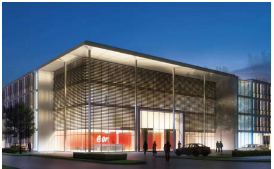
Referenzobjekt: E.ON, Regensburg
